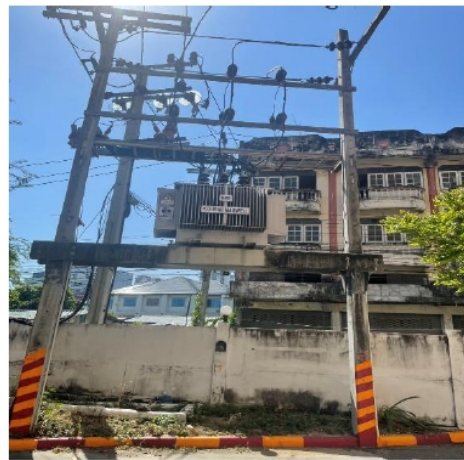
รูปที่ 2.4.5.2 หม้อแปลงไฟฟ้า ชุด B
