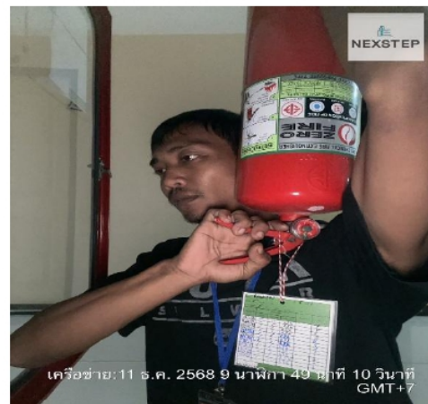
รูปที่ 2.4.6-7 ดับเพลิงมือถือ ชนิด CO2
