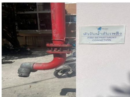
รูปที่ 2.4.6-3 หัวรับน้ำดับเพลิงภายนอกอาคาร
