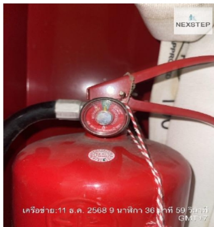
รูปที่ 2.4.6-6 ดับเพลิงมือถือ ชนิด ABC ขนาด 10 ปอนด์
