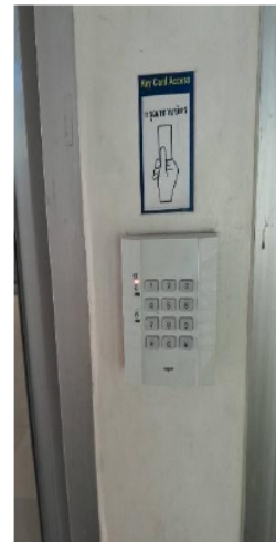
รูปที่ 2.4.9-1 ระบบควบคุมประตูอัตโนมัติ
